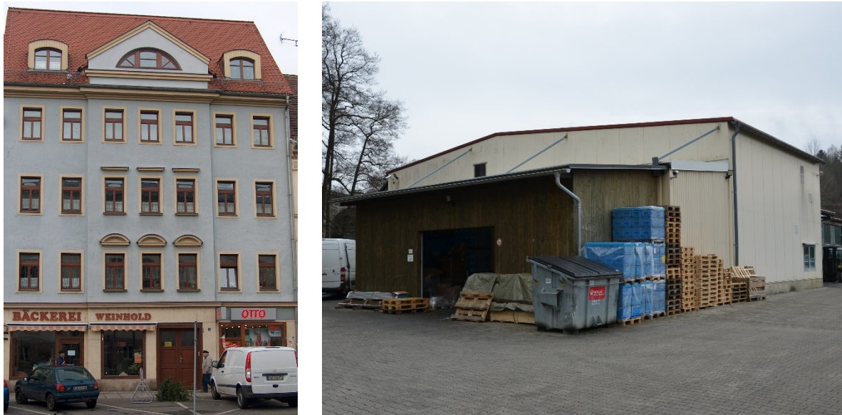
Abbildung 4: Eingelagertes Gewerbe (Handwerksbetrieb und Verkaufsfläche) in einem Wohn- und Geschäftshaus (links); Hallenkonstruktion für produzierendes Gewerbe (rechts).
